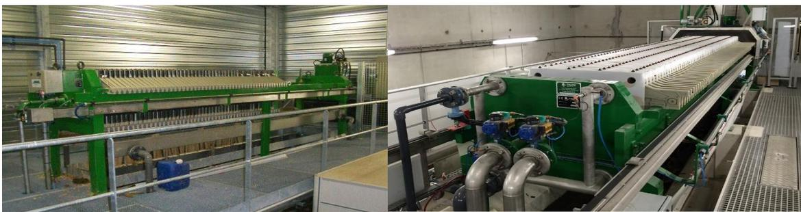
**Figure 23:** Déshydratation Mécanique des boues par filtre-presse à plateaux (Faure équipement 2022)
