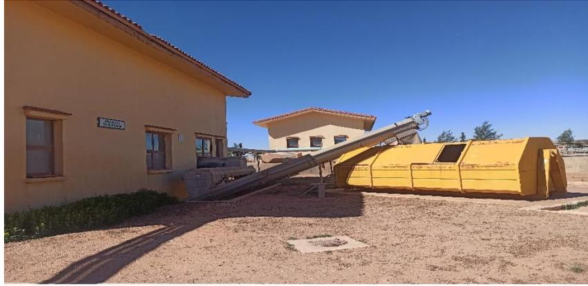
**Figure 24:** évacuation des boues déshydratée sur la baine (Photo prise sur terrain STEP d'Ain Sefra Mars 2023)
