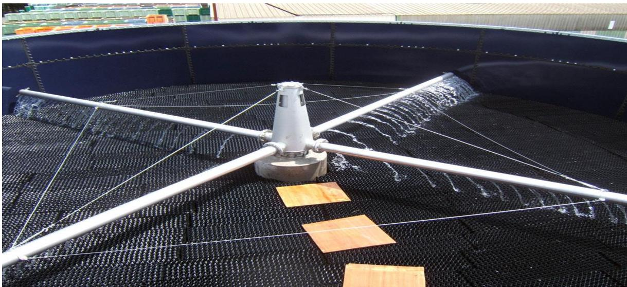
**Figure 16:** Modèle d'un Lit bactérien
