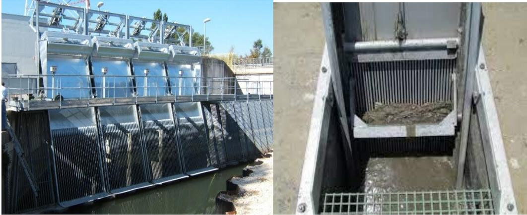
**Figure 2:** Schéma dégrilleur en amont (MADANI BESADIK)
