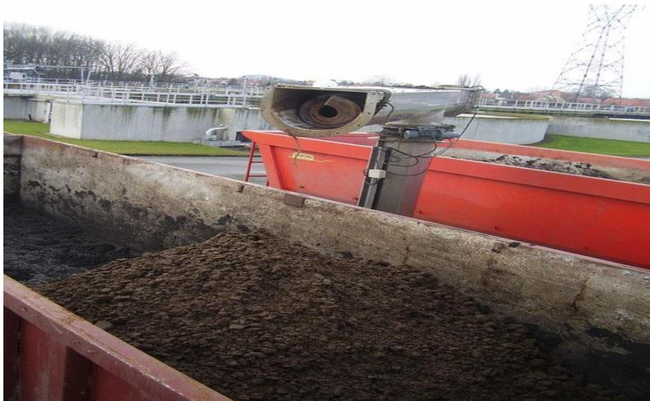
**Figure 19:** Stabilisation des boues par chaulage (OPAL INGÉNIERIE 2022)
