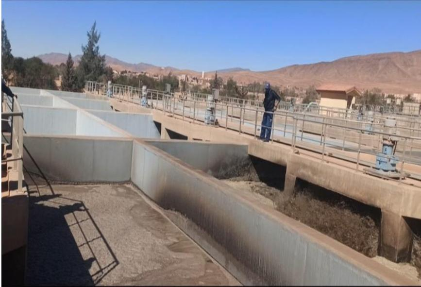
**Figure 14:** Bassin biologique ou d'aération (Photo prise sur terrain STEP d'Ain Sefra Mars 2023)
