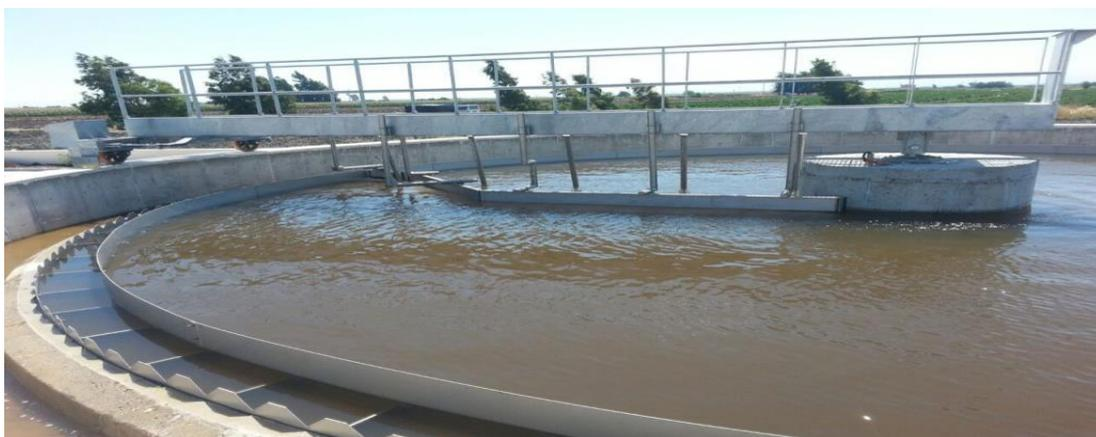
**Figure 9:** Décanteur circulaire
