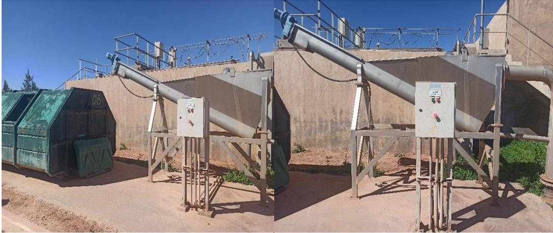
**Figure 4:** Classificateur à sables (photo prise sur terrain STEP d'Ain Sefra Mars 2023)
