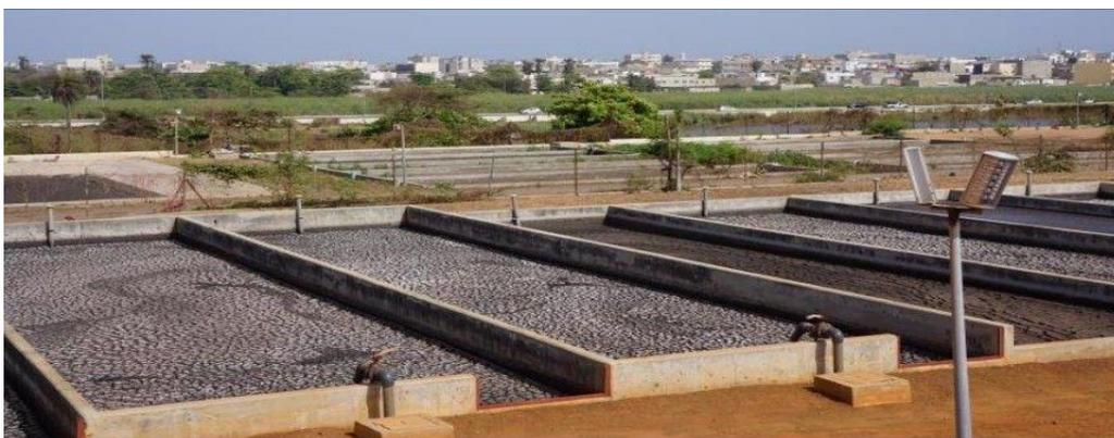
**Figure 25:** lits de séchage non plantés (Source : Eawag-Sandec à Dakar, Sénégal 2016)
